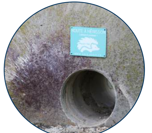
5. Pose d'un passage à faune
