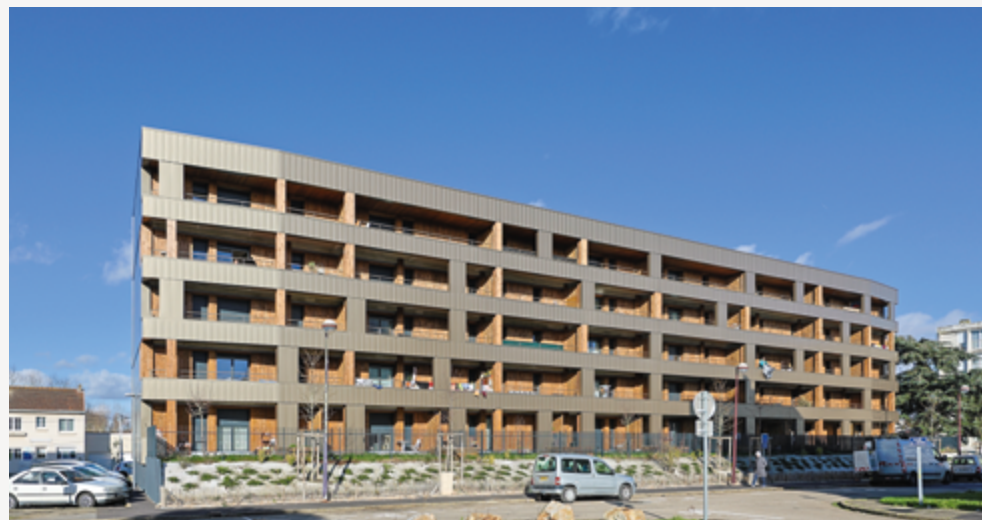
Dotée d'une nouvelle façade en métal et bois, le bâtiment, plus élégant aujourd'hui est aussi mieux isolé et permet de faire des économies d'énergie.
