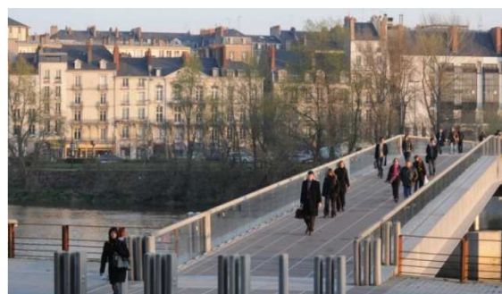
Passerelle Schœlcher (Nantes) - en dissociant piéton et vélo
